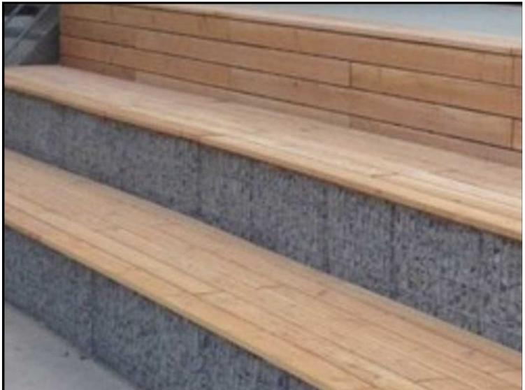
b) komplett mit Holzdielen verkleidete Rechteck-Stahlrohrkonstruktion, die an der Mauer und im vorgelagerten Pflasterbelag verankert ist.
